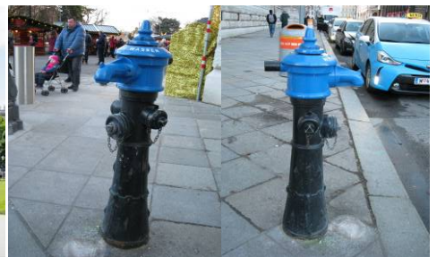
夏季は飲料水スタンドにもなる消火栓
